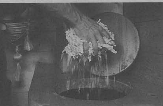
Statt mit Wasser zu spülen, muss nach jeder Benutzung Strukturmaterial zugegeben werden
