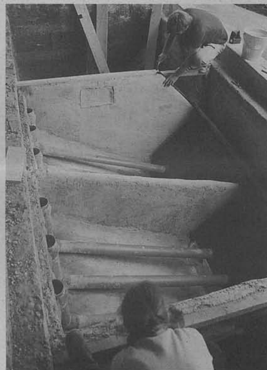
Kompost-Toilette in den Anfängen: beim Bau der Grosskammer-Komposttoilette 1985
